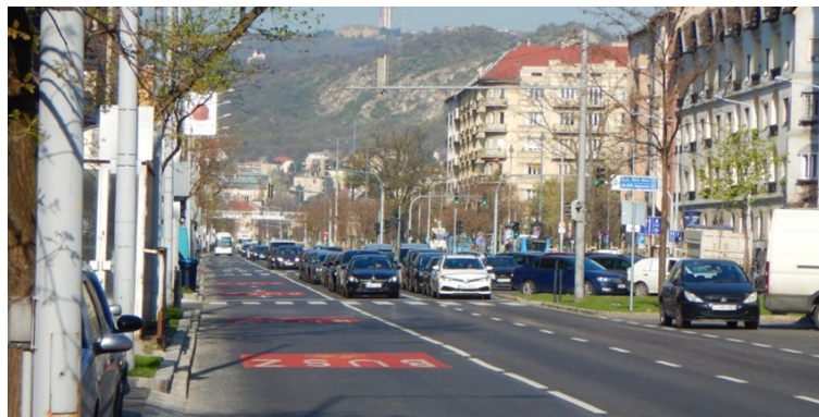
72. ábra: Bocskai út felújított szakasza
