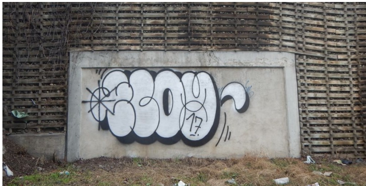
47. ábra Szerémi úti áttörés tervezett kerékpáros kapcsolatának elfalazott nyílása
