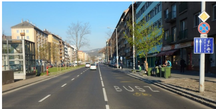
71. ábra: Bocskai út felújított szakasza
