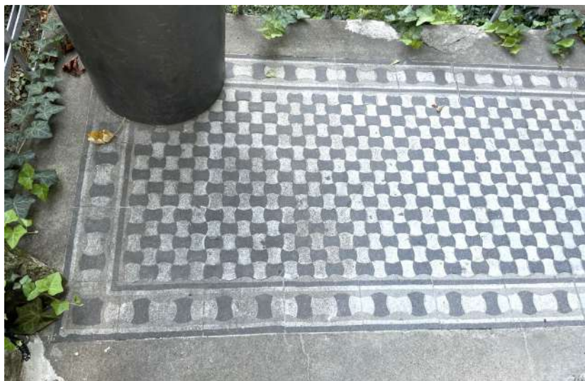
Az épület részlete, terrazzo burkolat a kertbe vezető lépcsőnél (Készítés dátuma: 2023. szeptember 27.)
