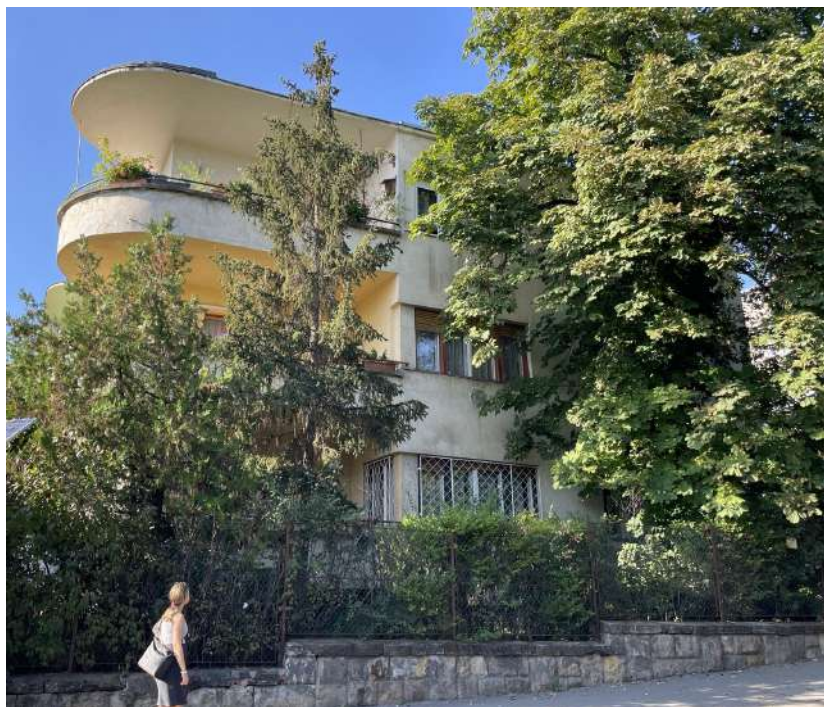
Az épület összképe délkelet felől (Készítés dátuma: 2023. szeptember 27.)
