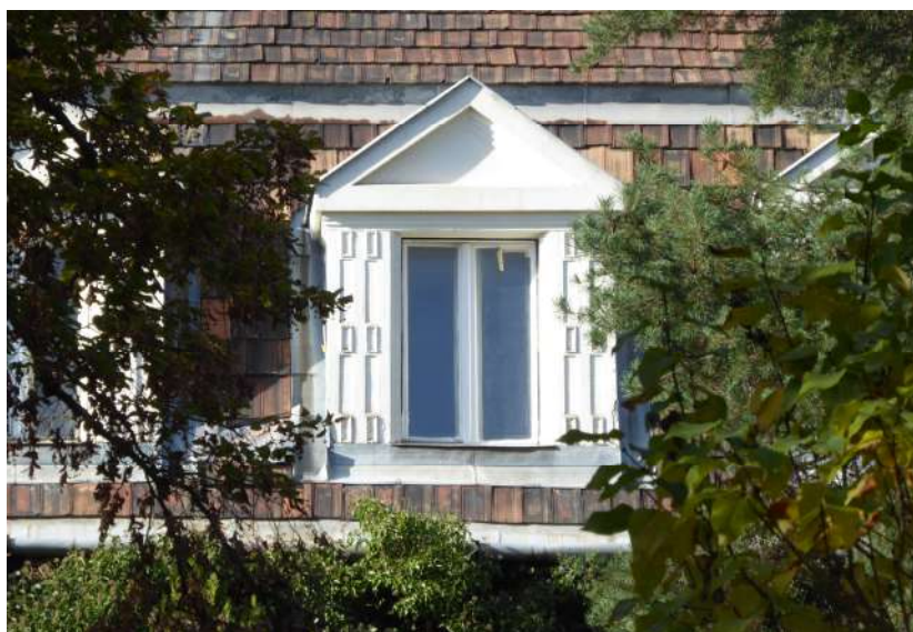
Az épület részlete, tetőtéri ablak (Készítés dátuma: 2023. szeptember 27.)
